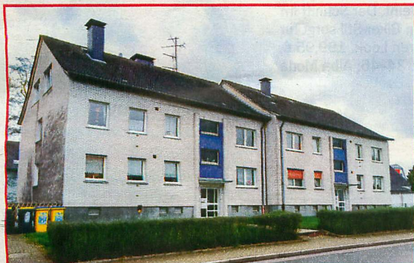
DAS HAUS Die Vermieterin hat den Betrag für die Heizkosten nicht an die Stadtwerke weitergeleitet
